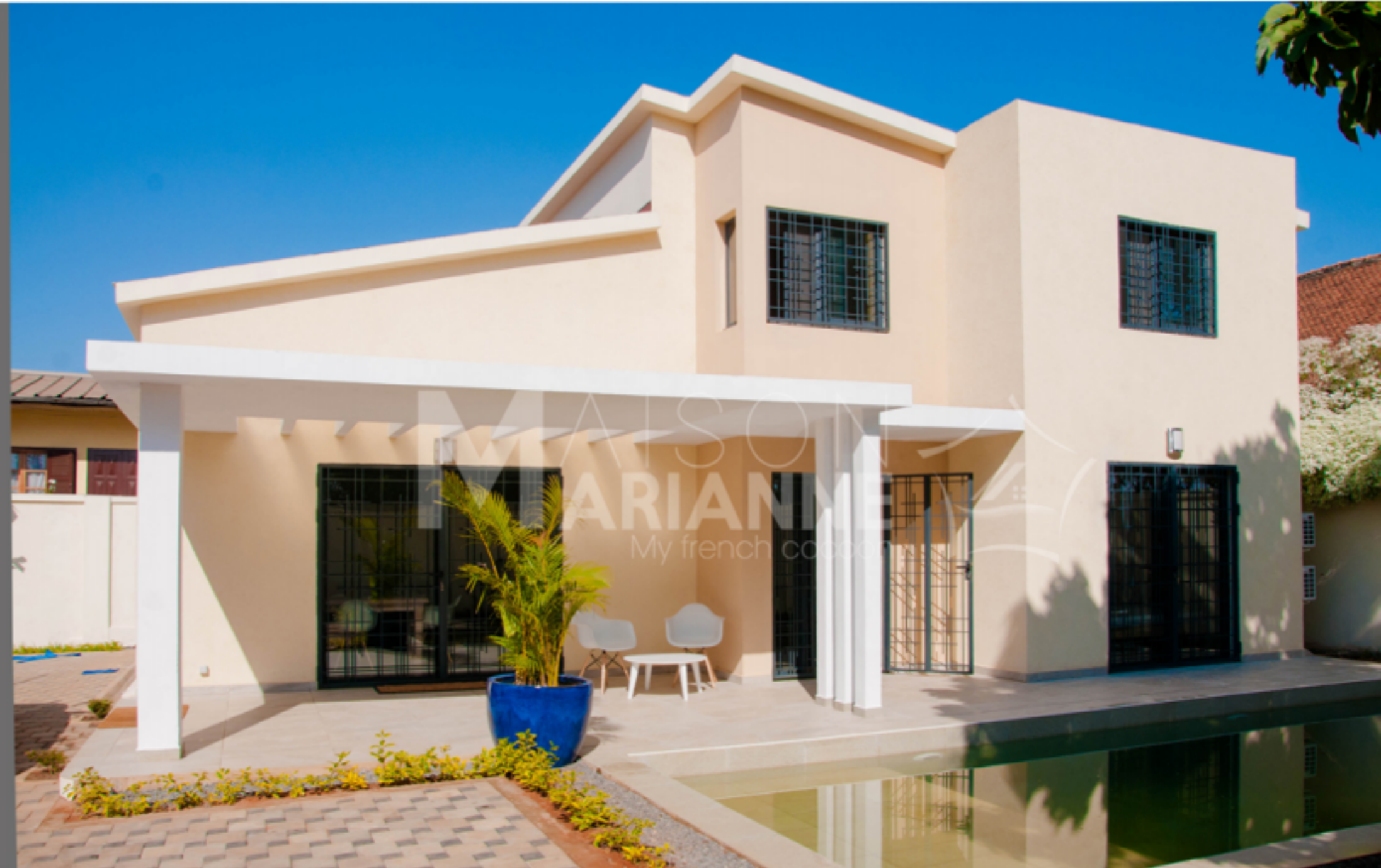
Photo réelle - Villa F5
